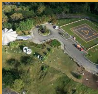
OBSERVATÓRIO NUCLEAR DE ANGRA
